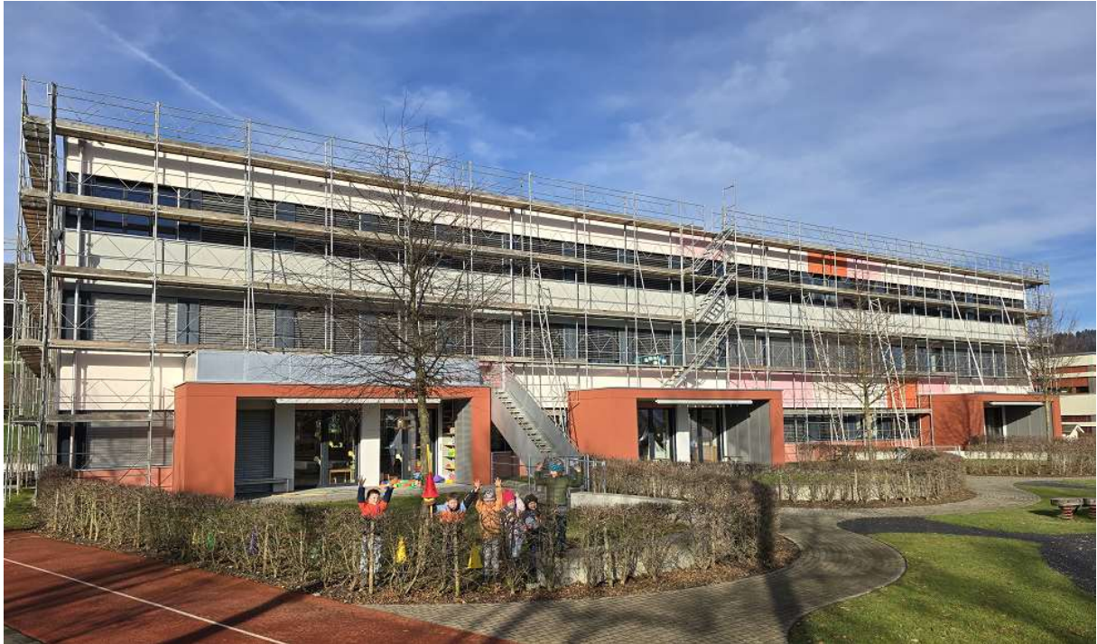
Bildlegende: Die Aufstockung des Kindergartengebäudes geht zügig voran
