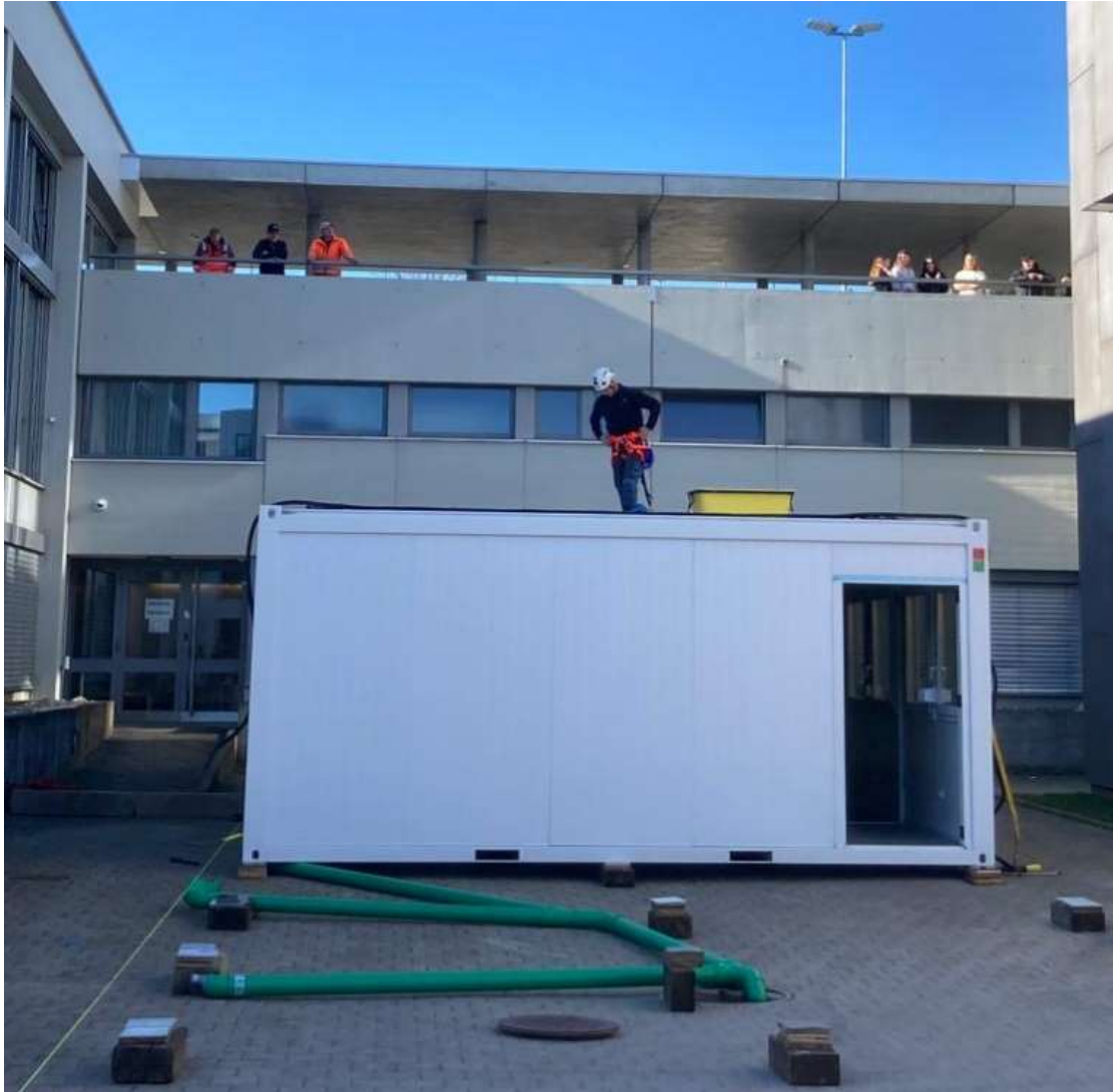
Bildlegende: Mit Spannung wird auf dem Schulhausgelände verfolgt, wie der Pavillon aufgebaut wird.
