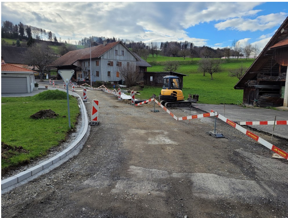
(Bildlegende:.) Strassen-/Kanalisationssanierung im Hof/Dominikusweg
