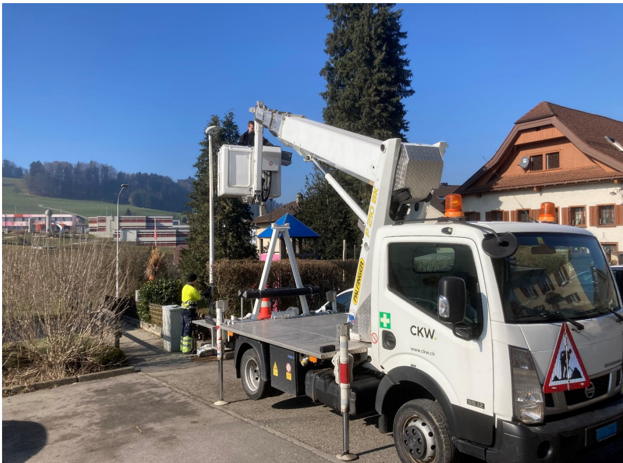
(Bildlegende:) Montage der neuen LED-Leuchten
