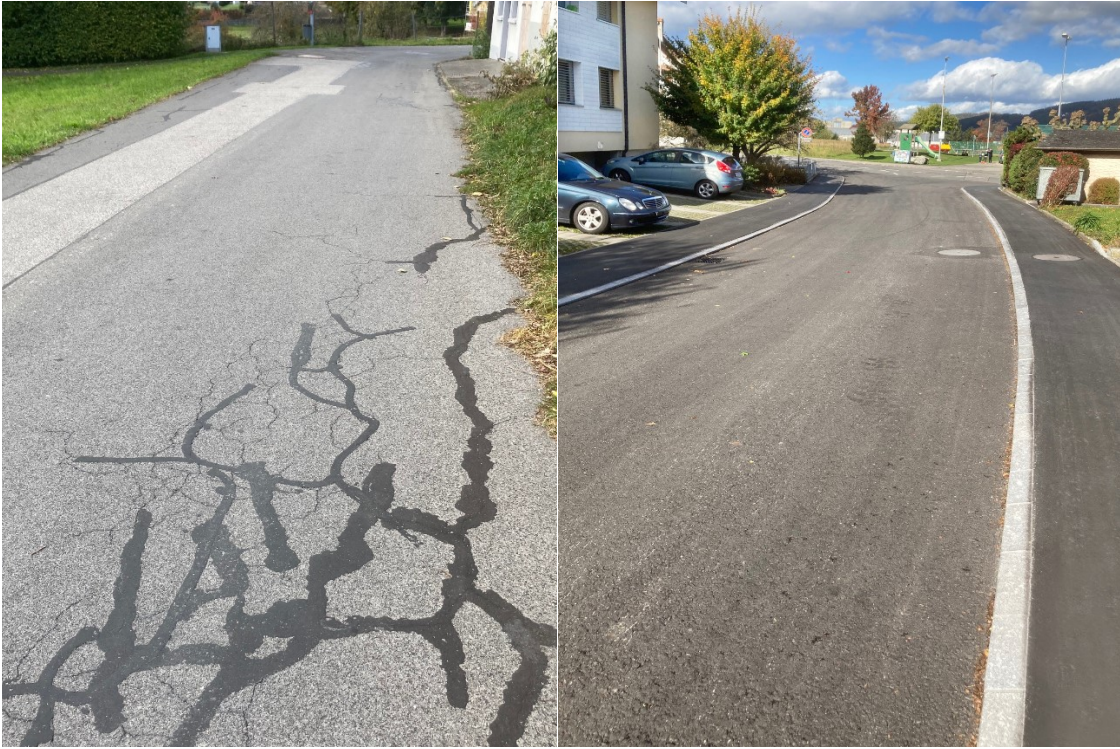
(Bildlegende:) Strassensanierung an der Kreuzstrasse; vorher und nachher
