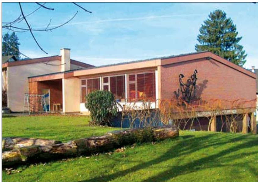
Sanierungsbedürftig: Das Pfeffiker Kindergartengebäude soll für 100 000 Franken auf Vordermann gebracht werden. (Foto: Silvio Bertschi)
